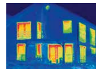
Vorher hoher Wärme- und Energieverlust (Rot)
